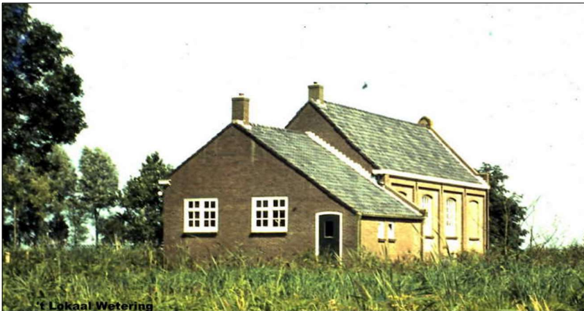
't Lokaal of Ned. Herv. Kapel aan de Wetering, afgebroken in 1986.
